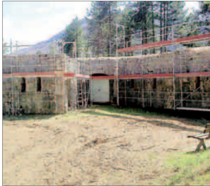
Il forte al passo Cimirlo con le impalcature per i lavori di restauro
